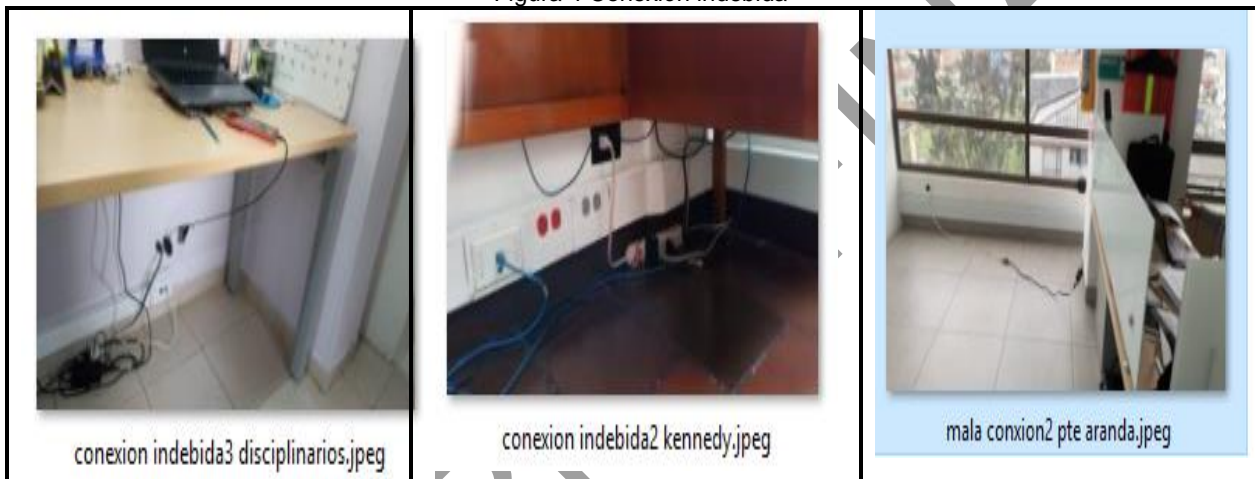
Figura 4 Conexión indebida
