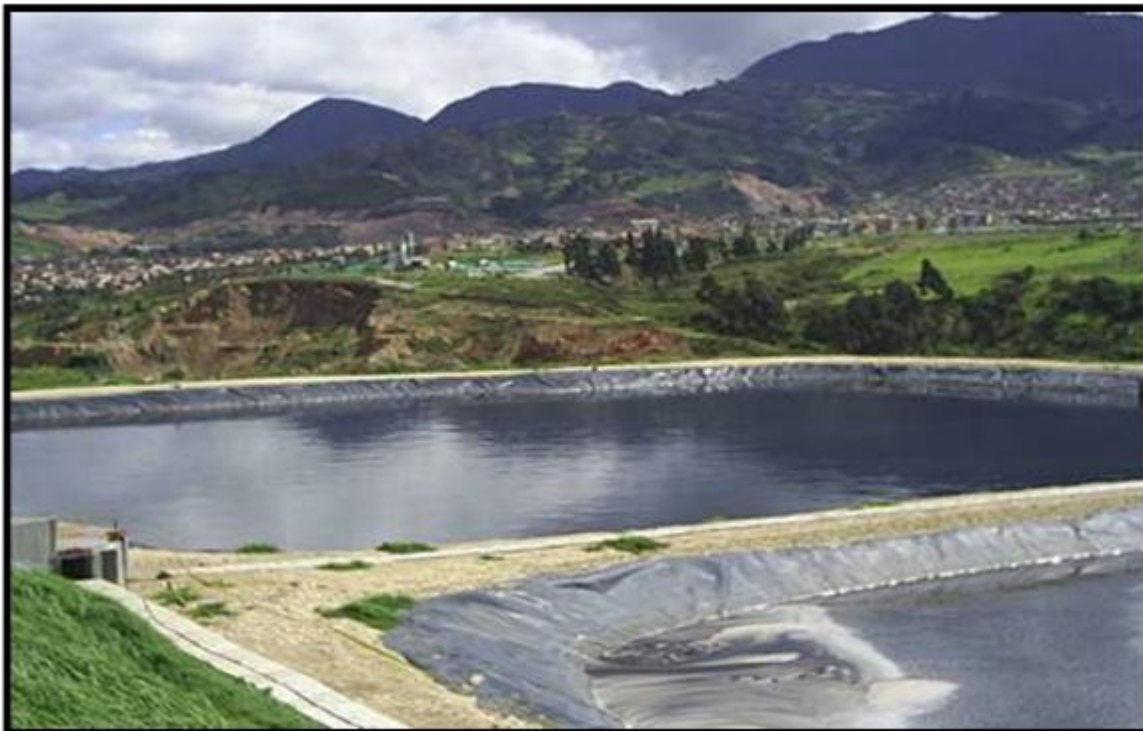
Foto: Tanques de tratamiento lixiviados RSDJ
